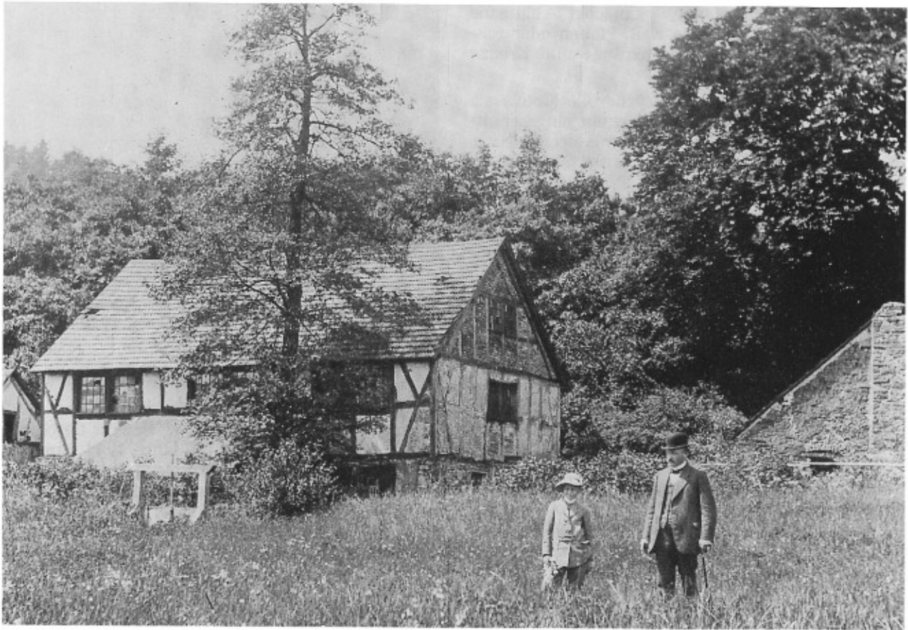
Im Bereich der ehemaligen Schleiferei, heute noch „die Schleif“ genannt, stand vermutlich der 1791 genehmigte dritte Hammer der Hütte Jünkerath. Die Ruinenreste (Steinhaufen), rechts im Bild, sind wahrscheinlich die Überreste dieses Hammers. Die Schleiferei mit Schuppen, links, ist als Fachwerk gebaut, das erst im 19. Jahrhundert in der Eifel üblich wurde. Da auch die Schleiferei mit Wasserkraft betrieben wurde, baute die Werksleitung sie an die Stelle des nicht mehr genutzten Hammers, da hier der Hüttengraben die entsprechende Schleuse aufwies, der das Gefälle für den Wasserradantrieb sicherstellte. Die Reste dieser Anlage sind heute noch zu erkennen /33/.
